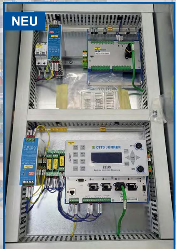
Die Modernisierung der Umrichtersteuerung zur Sicherstellung der Produktion
